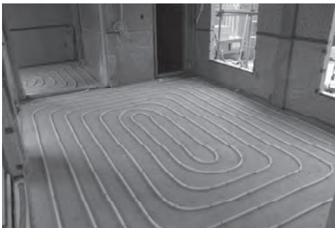
그림 10-33. 엑셀파이프 설치 (출처: 한옥기술개발)
