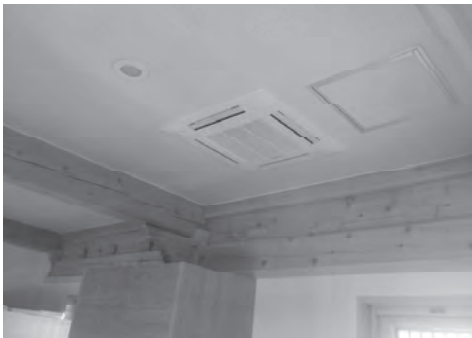
그림 12-35. 냉·난방기 설치(천장형) (서울 성북구 흥천사)
