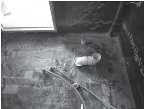
그림 12-8. 욕실 오·상수 배관 설치 (출처: 한옥기술개발)
