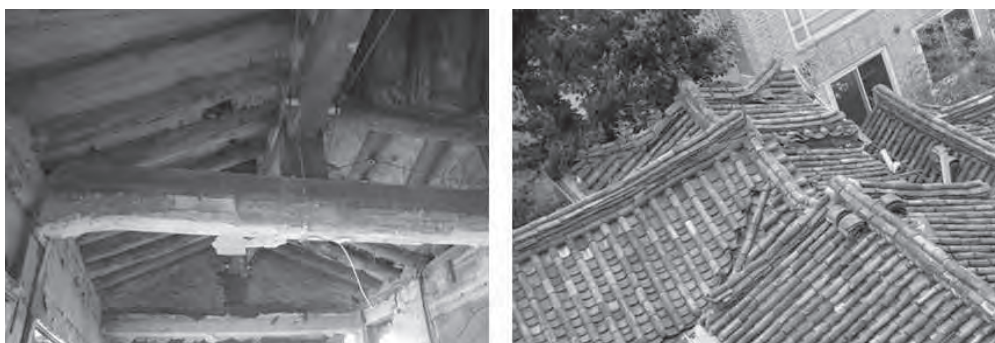
그림 9-4. 꺾임부 지붕구조(좌)와 합각부 지붕(우)
