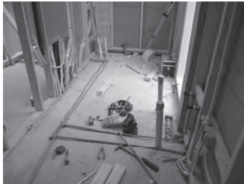
그림 12-9. 다용도실 배·상수 배관 설치 (출처: 한옥기술개발)
