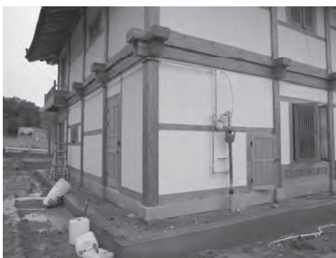
그림 12-45. 가스배관 설치 2 (출처: 한옥기술개발)
