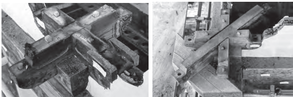
그림 4-7. 봉정사 대웅전 주상포작(좌)과 귀포작(우) 가로·세로 및 대각 3방향 포부재가 맞춤을 한 초제공
