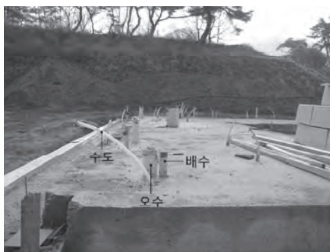
그림 12-5. 상하수도 배관 설치 1 (출처: 한옥기술개발)
