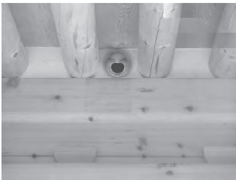
그림 12-47. 욕실 환풍기 연도 설치 (서울 성북구 흥천사)
