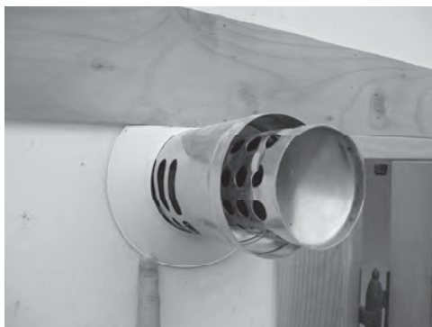
그림 12-46. 보일러실 연도 설치 (출처: 한옥기술개발)
