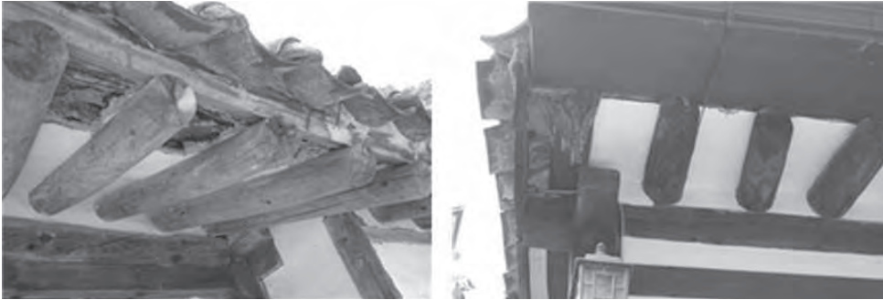
그림 7-3. 지붕 누수로 인한 연목 부식
