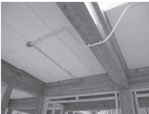
그림 12-27. 1층 전등배관 설치 (출처: 한옥기술개발)
