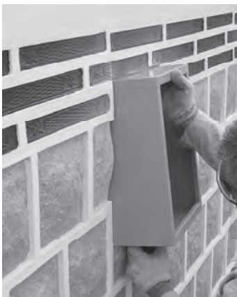
그림 12-29. 계량기함 설치 1 (출처: 한옥기술개발)
