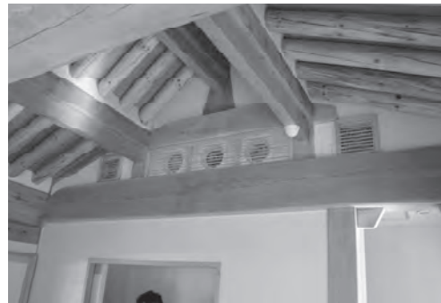
그림 12-36. 냉·난방기 설치(대공벽) (서울 성북구 흥천사)
