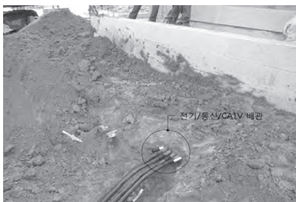
그림 12-13. 전기·통신 옥외배관 (출처: 한옥기술개발)
