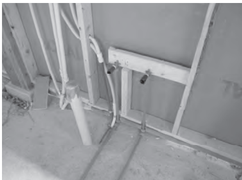
그림 12-10. 주방 배·상수 배관 설치 1 (출처: 한옥기술개발)
