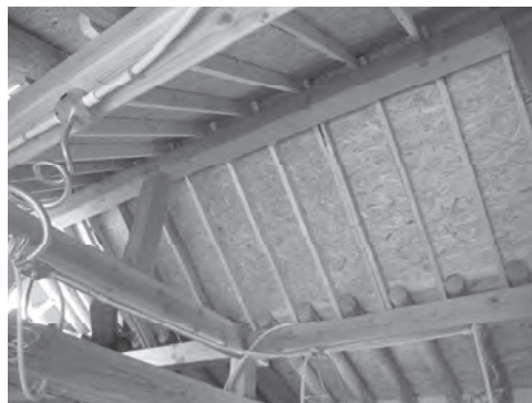
그림 12-28. 2층 전등배관 설치 (출처: 한옥기술개발)
