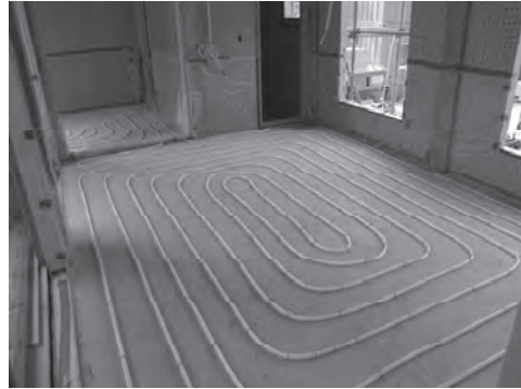
그림 12-33. 온수온돌 바닥 배관 설치 (출처: 한옥기술개발)
