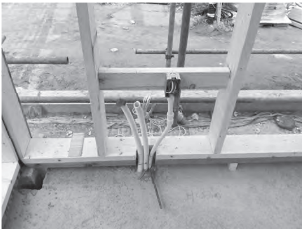
그림 12-20. 벽체 콘센트박스 설치 (출처: 한옥기술개발)
