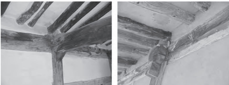
그림 7-4. 지붕 누수로 인한 도리 및 장혀 부식
