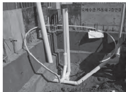
그림 12-6. 상하수도 배관 설치 2 (출처: 한옥기술개발)
